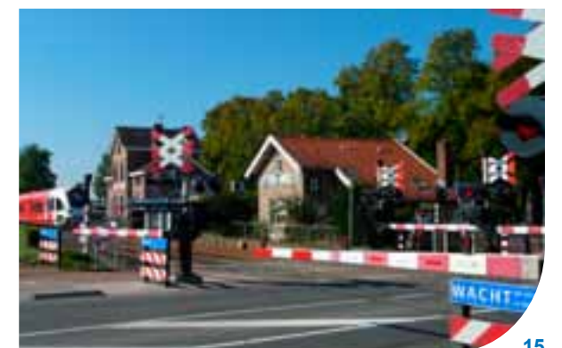
Zorg voor een veilige verkeerssituatie door de spoorwegovergang te ontlasten
