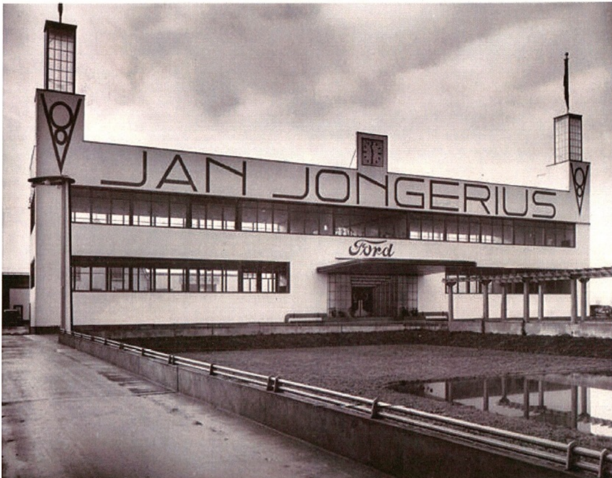
Figuur 3.1 Foto van het kantoorgebouw na oplevering in 1938
