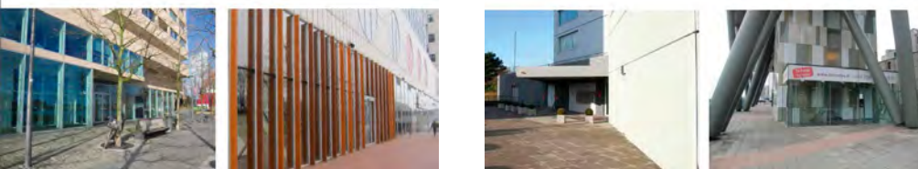
Voorbeelden van open, aantrekkelijke plinten
