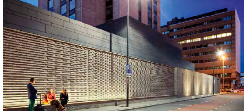
De architectuur is rijk in zijn materialisatie en detaillering. De wandafwerking na sloop parkeergarage aan NH hotel.
